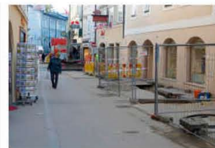
Linzer Gasse: Die Bauarbeiten haben begonnen. Foto: Stadt Salzburg
